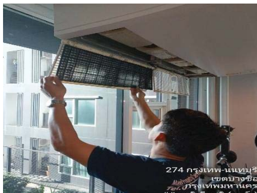
ล้างเครื่องปรับอากาศและแผ่นกรองอากาศพื้นที่ส่วนกลาง
