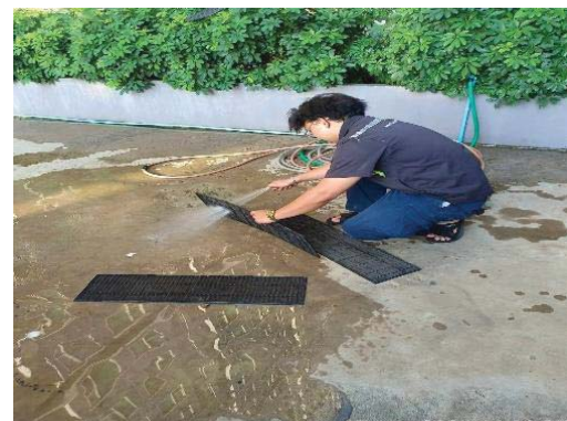
ล้างเครื่องปรับอากาศและแผ่นกรองอากาศพื้นที่ส่วนกลาง
